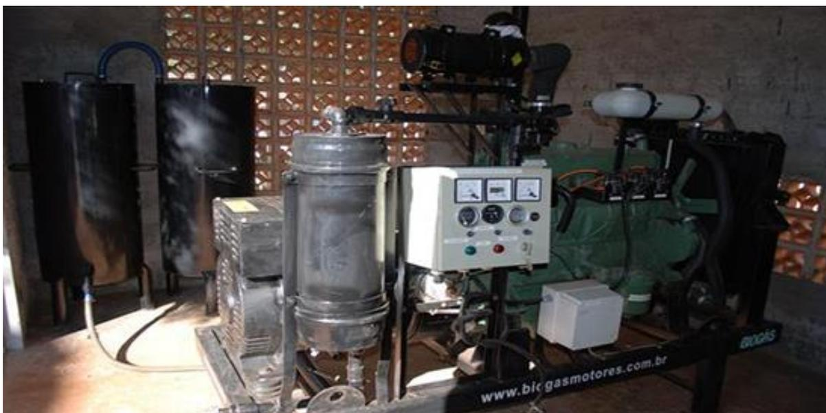
Figura 2.30 - Grupo Motor Gerador a biogás de 50 kVA da Biogás Motores.
